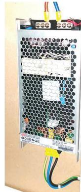
Nella scelta dell'ubicazione del DRIVER di alimentazione e dei materiali a contatto con l'apparecchiatura, considerare la compatibilità con la massima temperatura raggiungibile dall'involucro.
