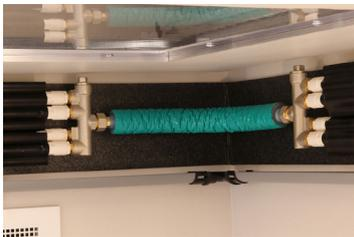
Collegare due moduli presenti su pareti differenti tramite una curva in tubo multistrato  $\text{\O}16 \times 2$  e due raccordi dritti.
