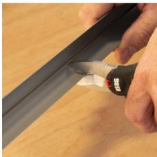
Tagliare a misura la canalina di raccolta, codice 3756.04.00. La lunghezza dovrà prevedere il montaggio dei relativi tappi, giunzioni o raccordi.
