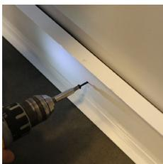
Fissaggio della struttura di staffaggio con viti o fischer  $\text{\O} 6,5$ mm in corrispondenza delle forature precedentemente eseguite (si veda passaggio 2)
