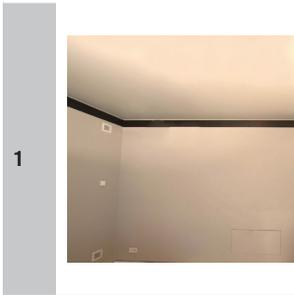
Applicare la fascia isolante perimetrale, codice 3754.00.02, sulla parete. Utilizzare una bolla laser per tracciare un livello. L'incollaggio della fascia deve essere preciso in quanto i supporti a muro la utilizzeranno come riferimento.
