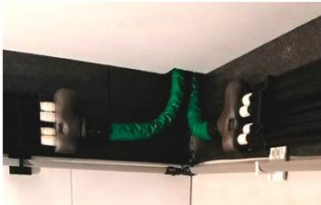
Collegare all'utenza di mandata il primo modulo del circuito; collegare all'utenza di ritorno l'ultimo modulo con tubo  $\text{\O}16 \times 2$  e raccordi da  $G1/2''$  M.
